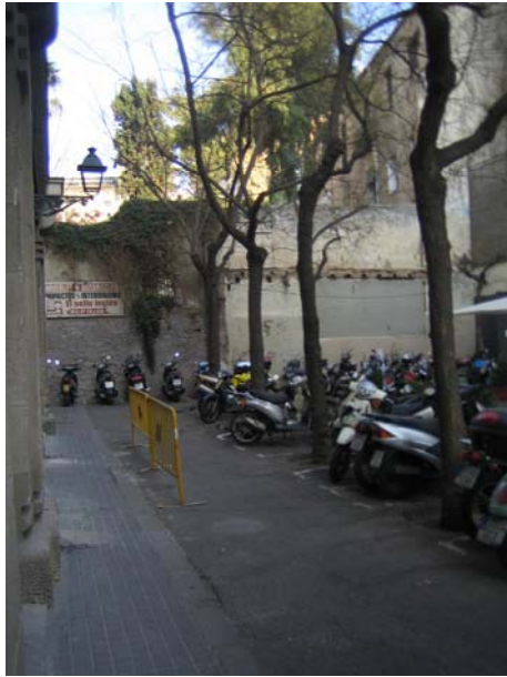
FOTO 1. Vista de la zona abans d'iniciar-se l'excavació de la rasa
