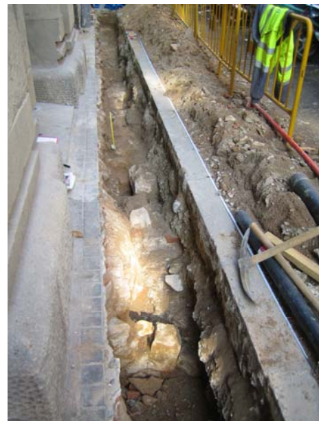
FOTO 4. Visió general de les estructures localitzades (Tram 2)
