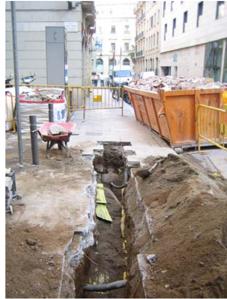
FOTO 2. Vista de la rasa amb serveis actuals a la zona del C. Sagristans (Tram 1)
