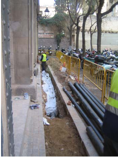
FOTO 5. Cobertura de les estructures amb geotèxtil (Tram 2)
