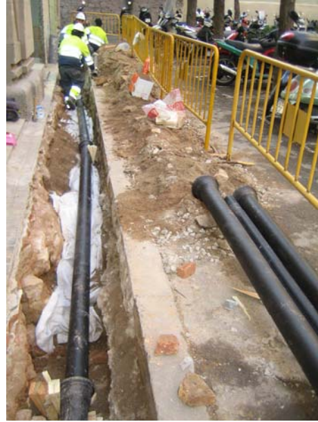
FOTO 6. Col·locació dels tubs per sobre les estructures (tram 2)
